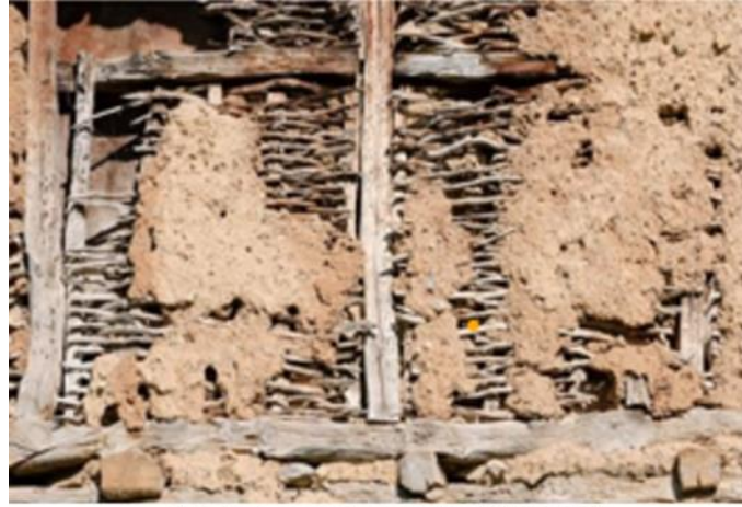
Dal-örgü-çamur harç sıvalı yıkık Neolitik barınak duvarı (Foto: wikipedia.org)
